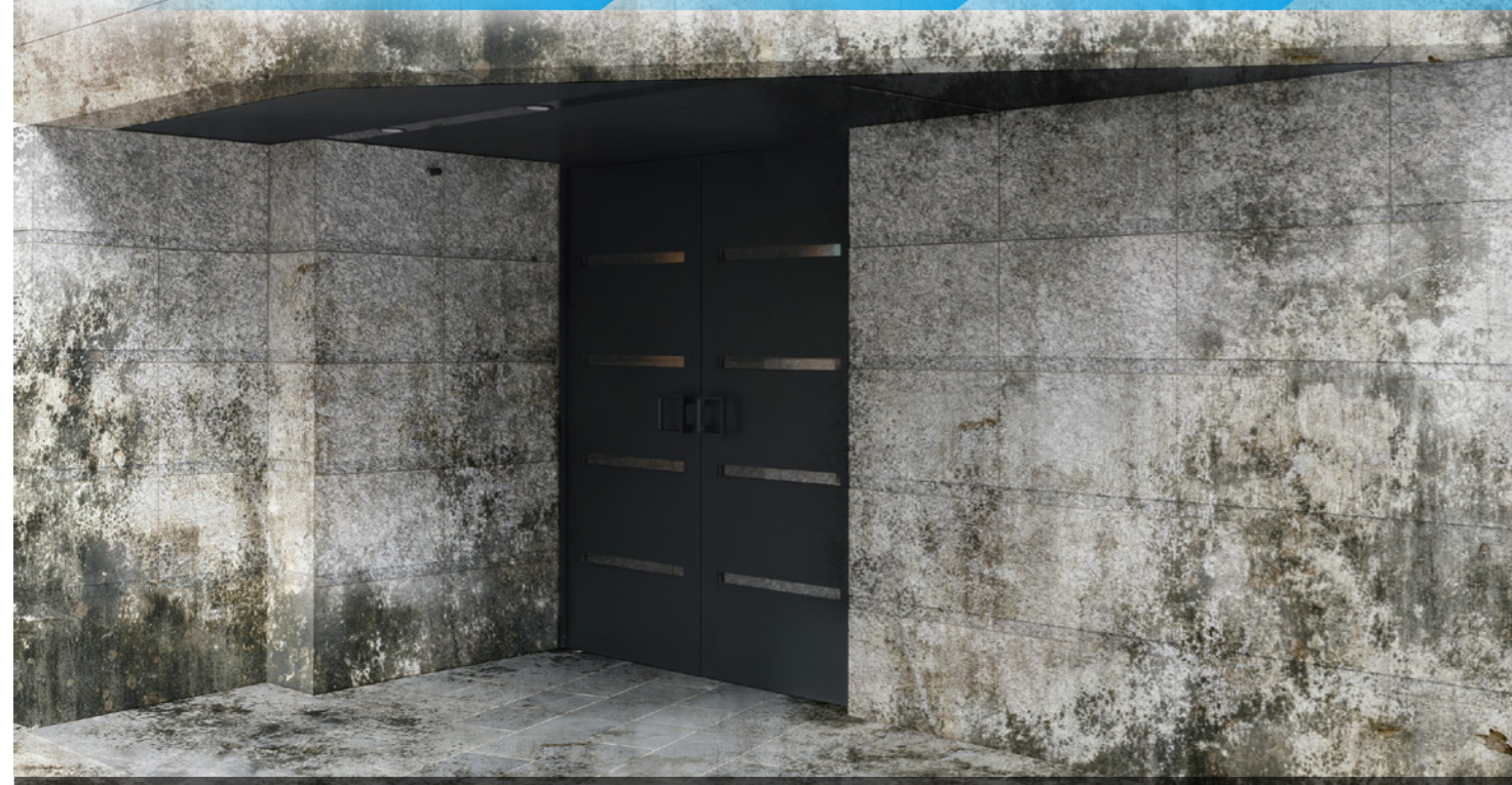
もともと綺麗な外壁も、数年経過すると様々な汚れが目立つようになります。
