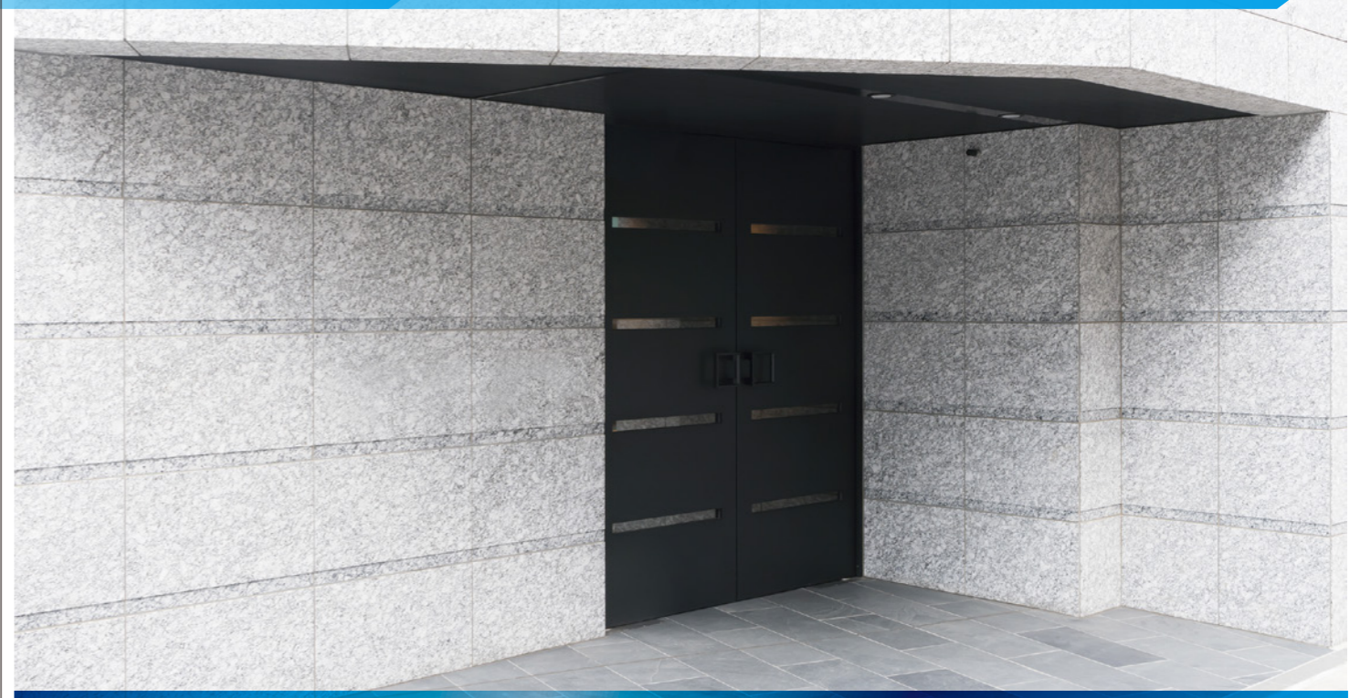
ナノメンテSB工法により、汚れが綺麗に落ち、その状態を数年間維持することができます。
