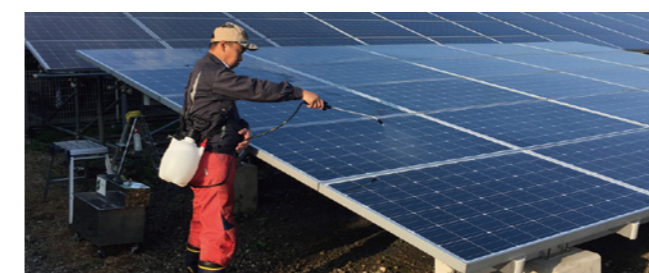
【上】テスト洗浄の結果 【下】コーティング水塗布の様子
